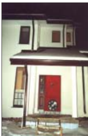
Mērījumi ar iekārtu BlowerDoor
